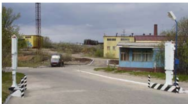
Portal radiation monitor «Yantar-2L» installed at FSUE «10 SRZ»
