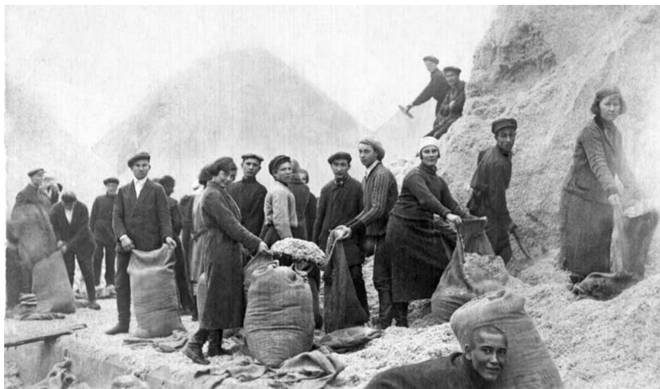
На строительстве Южного Ферганского канала, 1940 г. Фото из семейного архива
