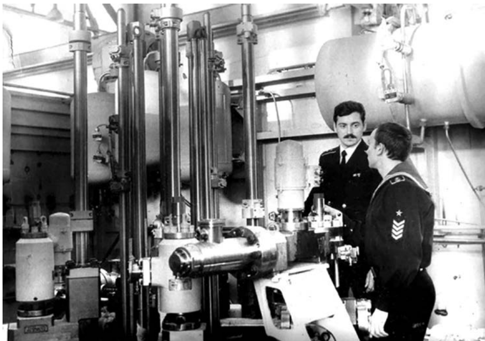
Реакторная выгородка установки «Борт-70»
