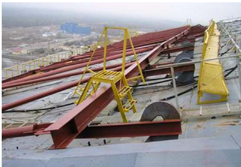
Рис. 8. Соединительная ферма на опорах, приваренных к монтажным крюкам южных щитов покрытия (мероприятие №8). Верхняя площадка для прохода вдоль фермы.
