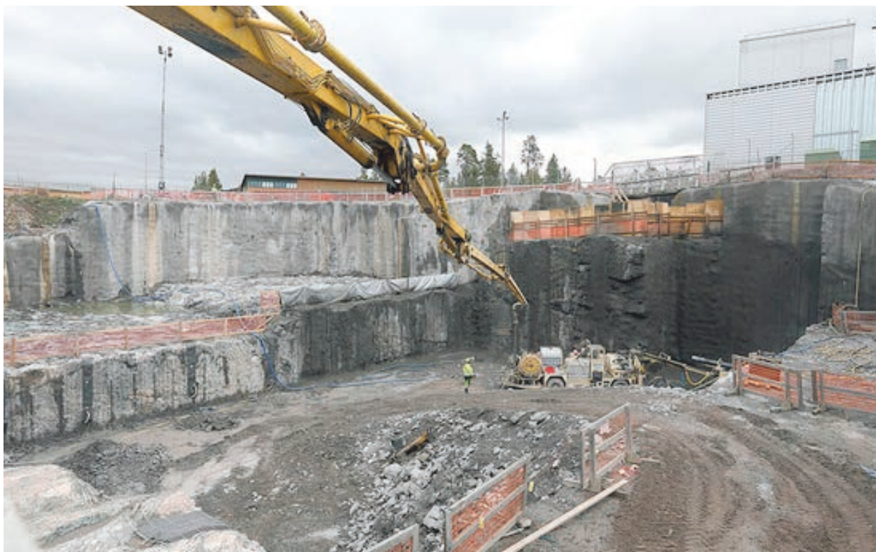
Рис. 2. Котлован для заложения фундамента будущего завода по инкапсуляции финского ОЯТ
