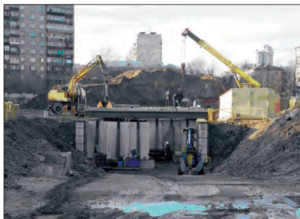
Рис. 7.2.11. Внешний вид радиационной защиты на хранилище № 4
