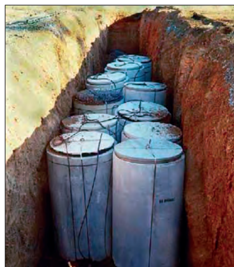
Рис. 1.5.2. Размещение бетонных контейнеров в траншее в Ок-Ридже
