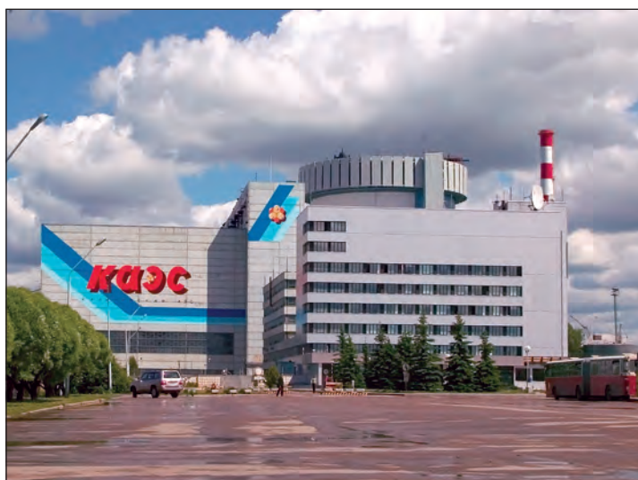
Рис. 4.2.2. Общий вид первого блока Калининской АЭС с реактором ВВЭР-1000
