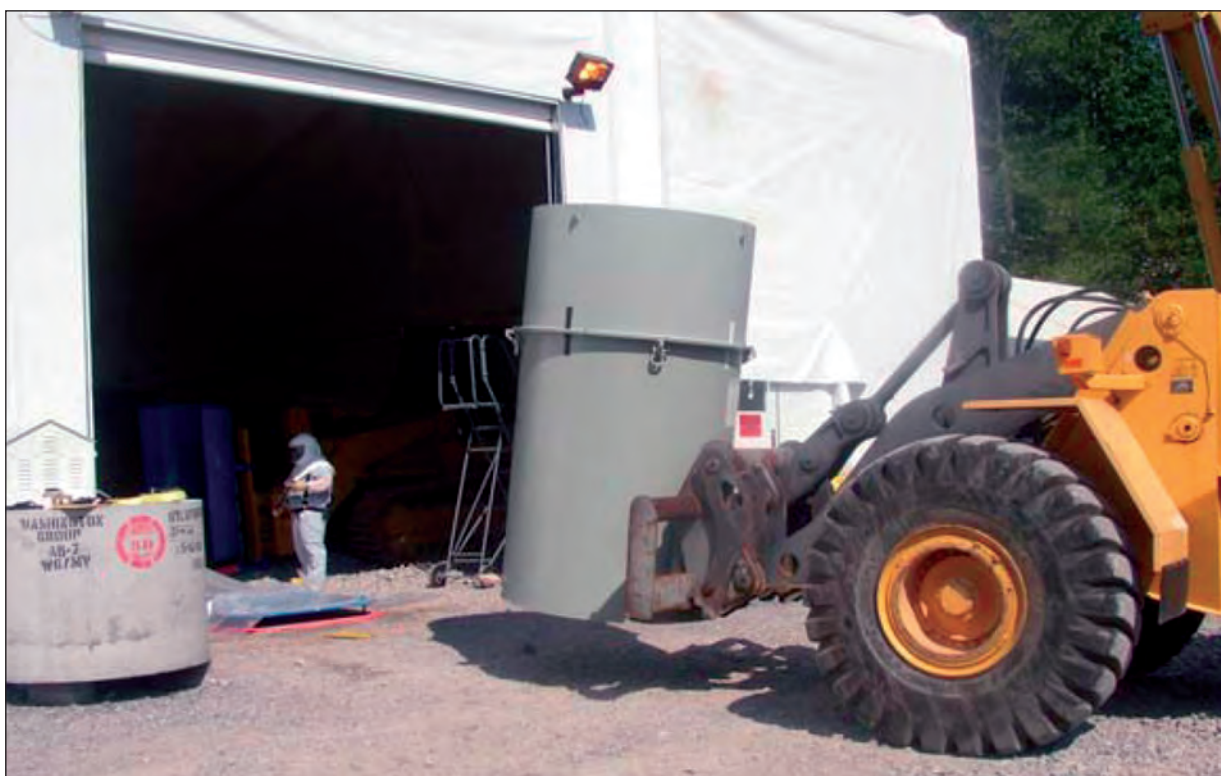
Рис. 1.5.4. Размещение переупакованных РАО в хранилище
