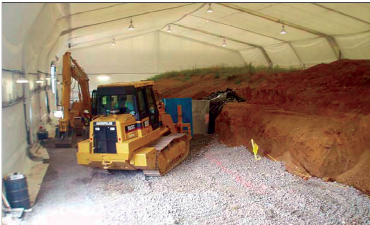
Рис.1.5.3. Процесс извлечения контейнеров из траншей для их переупаковки
