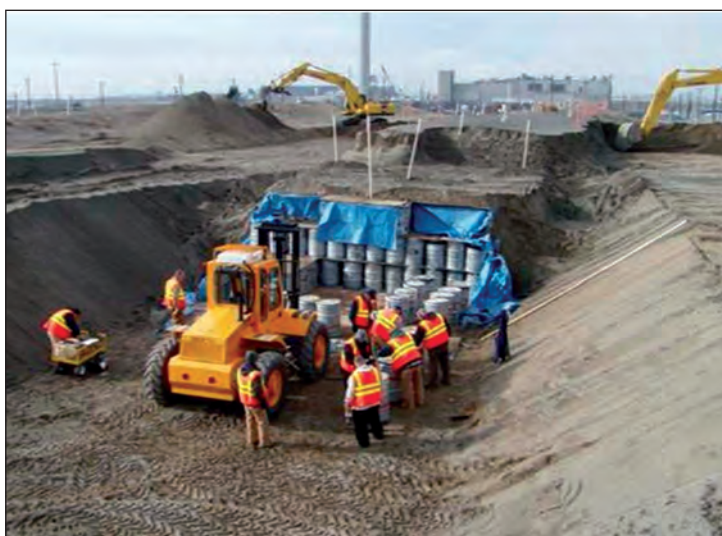
Рис. 1.5.1. Проведение работ в траншеях в Хэнфорде
