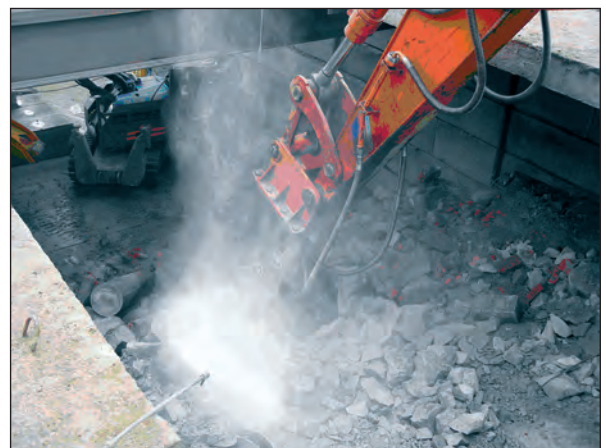
Рис. 7.2.10. Пылеподавление при ликвидации хранилища № 4
