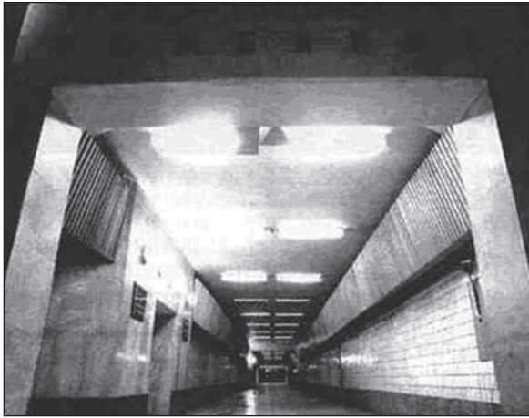
Рис. 2.1.3.4. Центральная улица в подземных сооружениях ГХК
