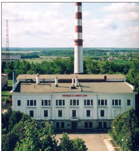
Рис. 4.1.1. Здание Первой в мире АЭС
