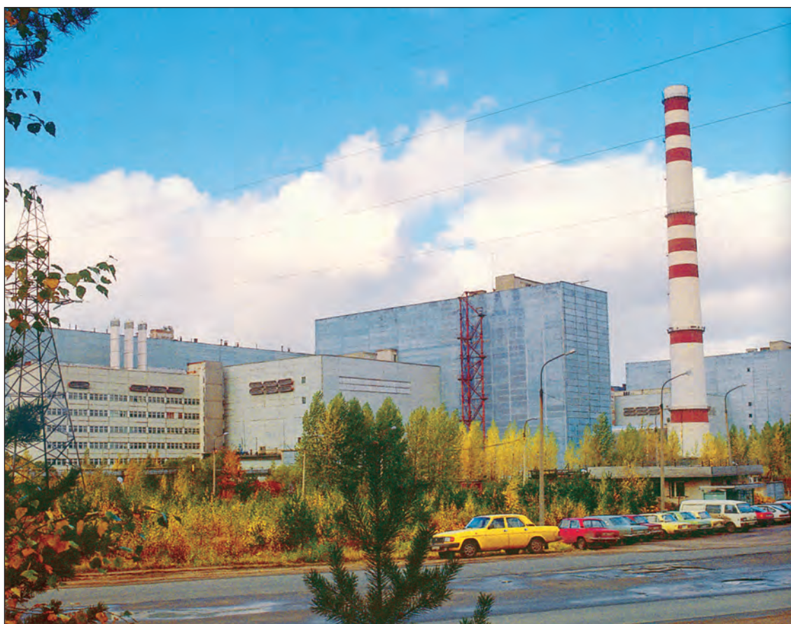
Рис. 4.2.1. Общий вид Ленинградской АЭС с реакторами РБМК-1000
