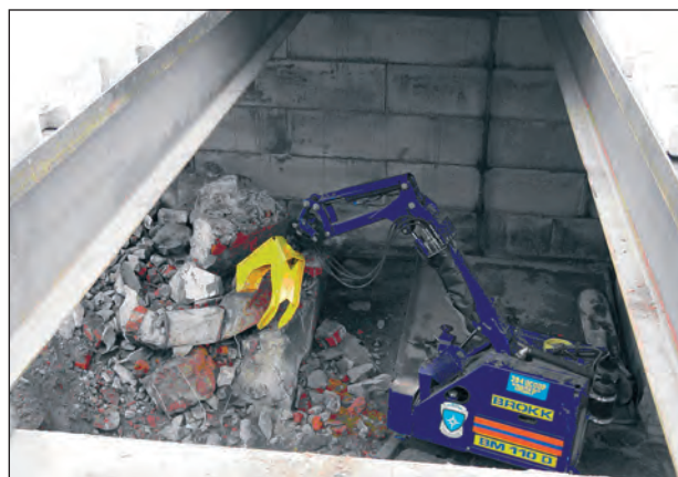
Рис. 7.2.12. Момент извлечения пеналя с высокоактивными отходами робототехническим средством «Brokk-110»
