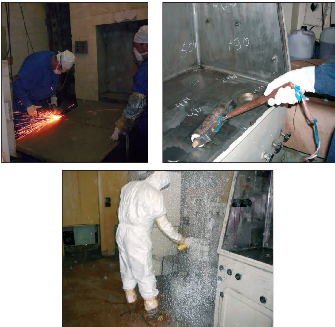
Рис. 3.4.7. Работы по дезактивации и утилизации загрязненного оборудования
