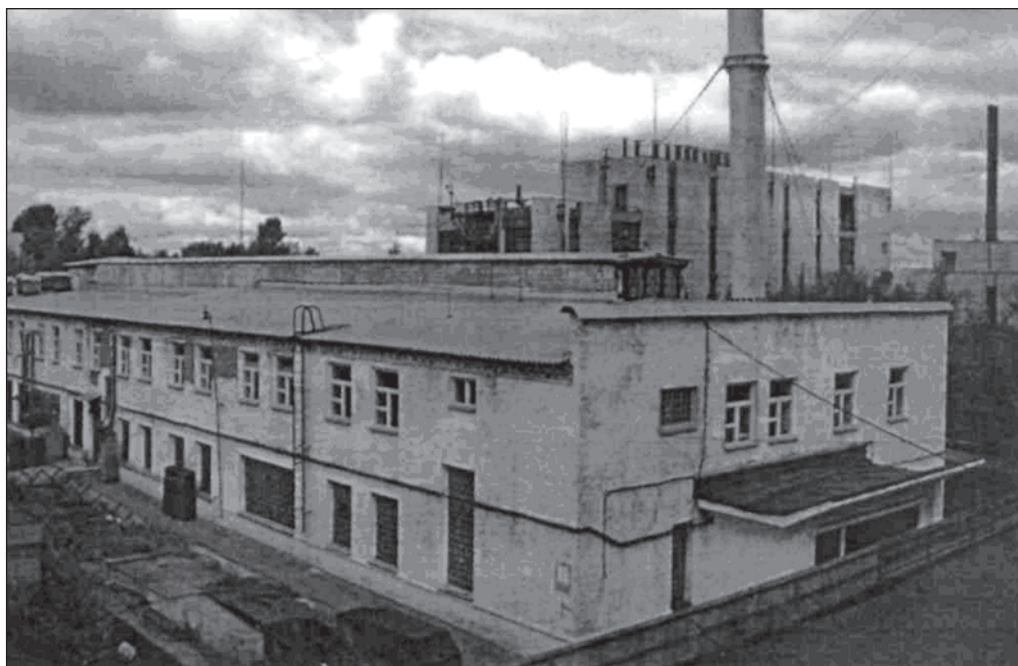
Рис. 3.3.1. Общий вид радиохимического корпуса № 8 в 2007 г. На фото видна 40-метровая труба для удаления газоздушных выбросов вытяжной вентиляции корпуса в атмосферу
