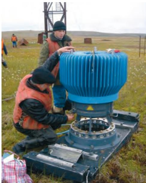
**Рис. 1.22.** Обследование РИТЭГа и подготовка его к транспортировке
