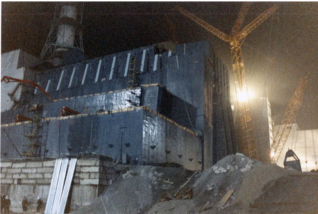
Рис. 30. Строительные работы на площадке ЧАЭС или круглосуточно.
