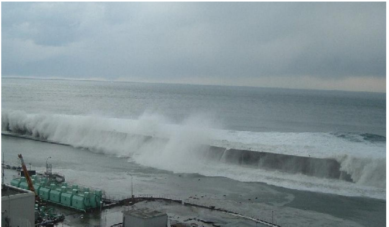
Рис. 35. Цунами преодолевает защитную дамбу (волнолом).
