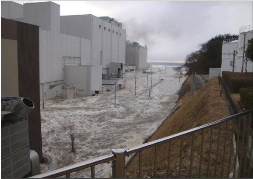
Рис. 36. Вода заливает АЭС Ф1.
