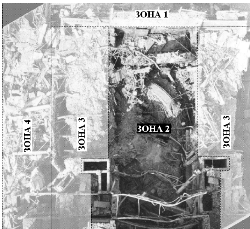
Рис. 13. Зоны потенциального пылеобразования при обрушении кровельных конструкций "Укрытия": ЗОНА 1 – обрушение западной стены; ЗОНА 2 – вибрация поверхности; ЗОНА 3 – сдув пыли из под падающих щитов и клюшек с опор; ЗОНА 4 – падение южных клюшек.
