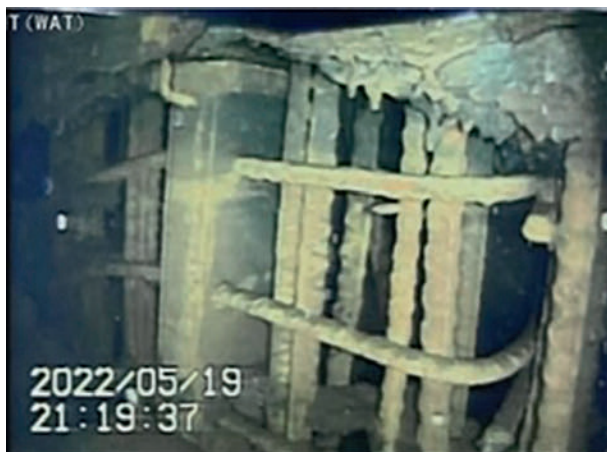
Рис. 33. Открытая стальная арматура (слева от двери)
