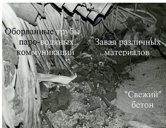
Рис. 16. Юго-западный квадрант пом.305/2. У пролома (прожога) в пом.304/3. Пол перед завалом покрыт «свежим бетоном»
