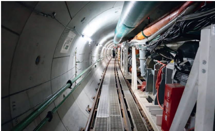
Рис. 16. Внутренний вид тоннеля.
