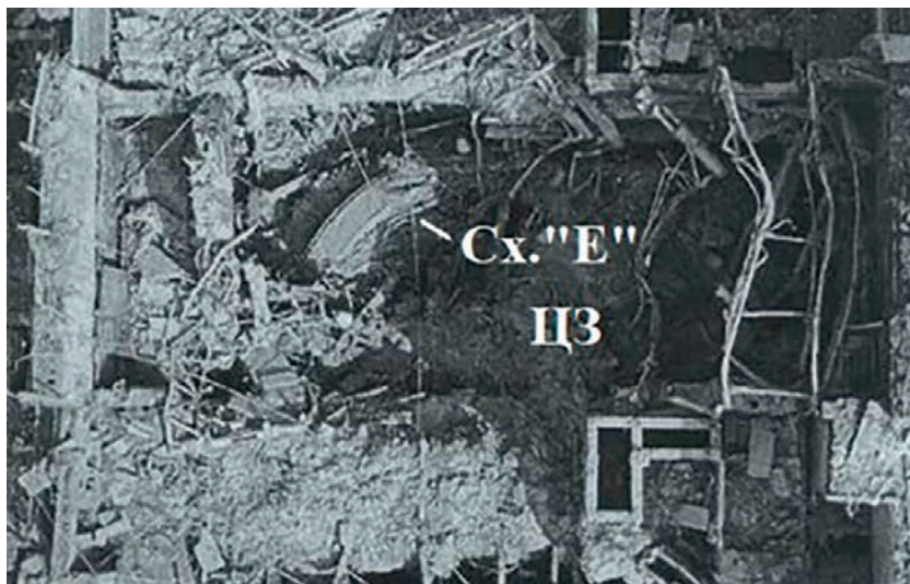
Рис. 4. Центральный зал после аварии. Съёмка с вертолёта
