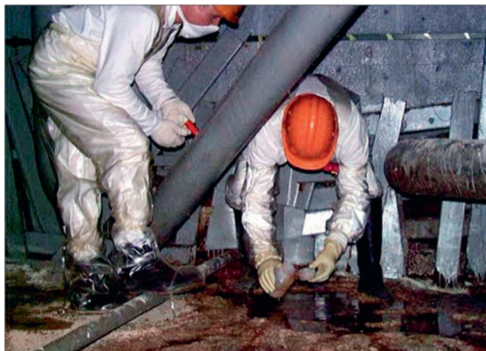
Рис. 19. Отбор проб воды в помещении бассейна-барботёра
