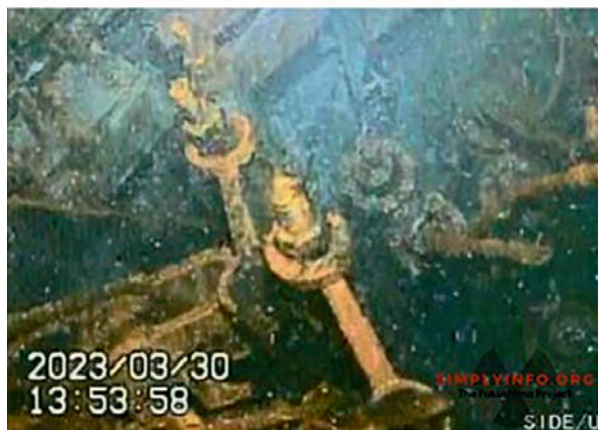
Рис. 31. Металлические конструкции реактора поверх застывших ТСМ
