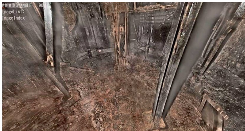
Рис. 6. Отложения (предположительно ТСМ) на основании пьедестала 2-го блока АЭС «Фукусима-1» (2018 г.)
