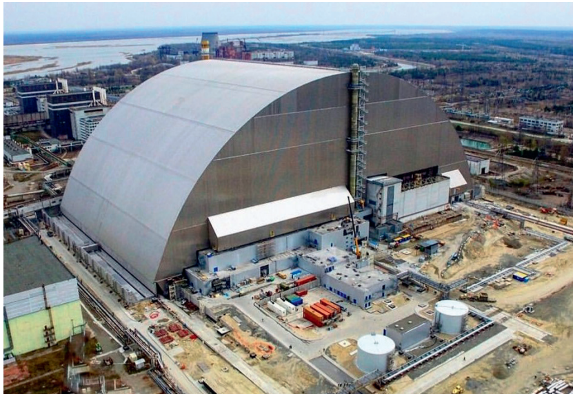
Рис. 2. Новый безопасный конфайнмент. Введён в эксплуатацию в 2019 г.
