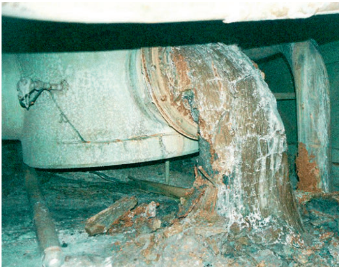
Рис. 3. Потоки застывшей топливной лавы, вытекавшие из клапана в парораспределительном коридоре
