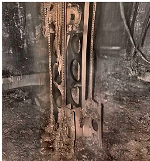
Рис. 14. Опора погрузочно-разгрузочной машины среди отложений на основании пьедестала
