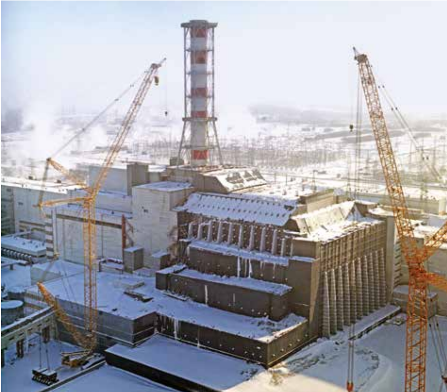
Рисунок 1.3. Зима 1987 г. Объект «Укрытие» построен. Фото: В. И. Ободзинский
