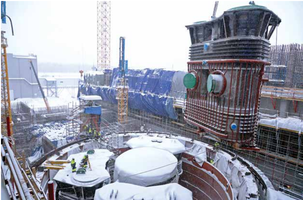
Рисунок 6.2. Монтаж реакторной установки БРЕСТ-ОД-300. Строительство уникального объекта осуществляется на территории Сибирского химического комбината (АО «СХК», предприятие Топливного дивизиона «Росатома») в рамках стратегического отраслевого проекта «Прорыв»
